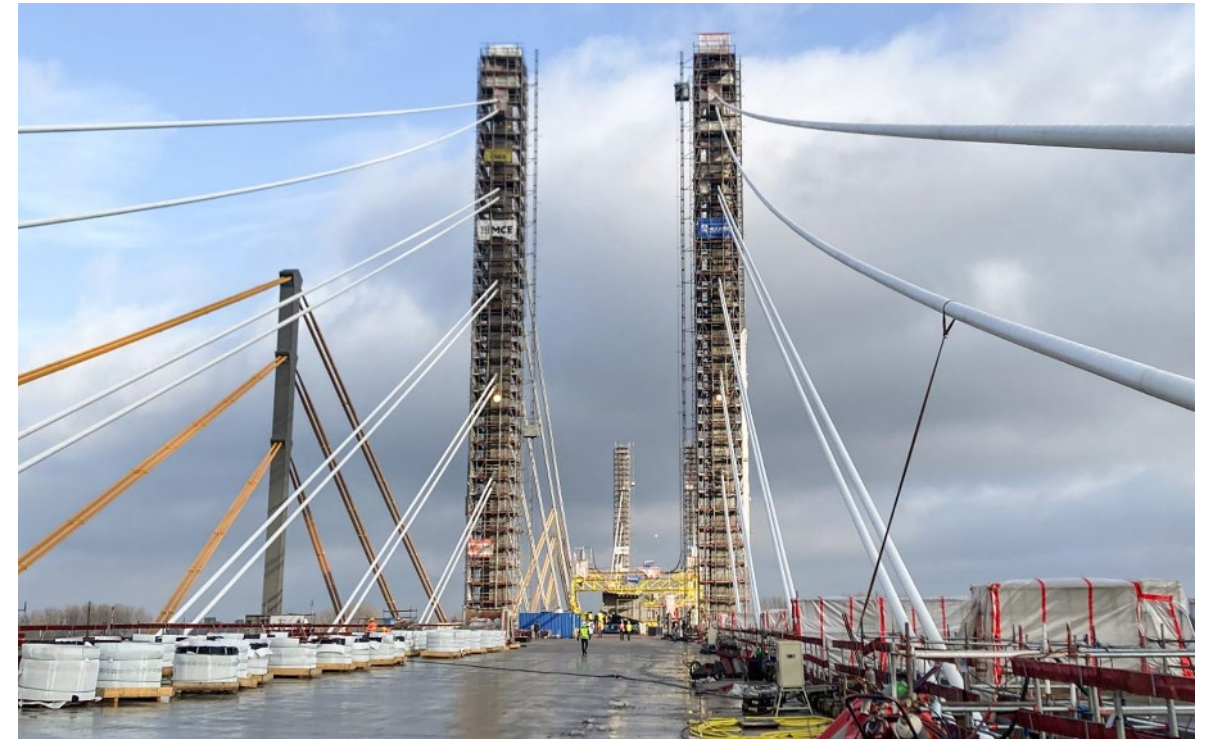
Ersatzneubau Rheinbrücke Duisburg-Neuenkamp
