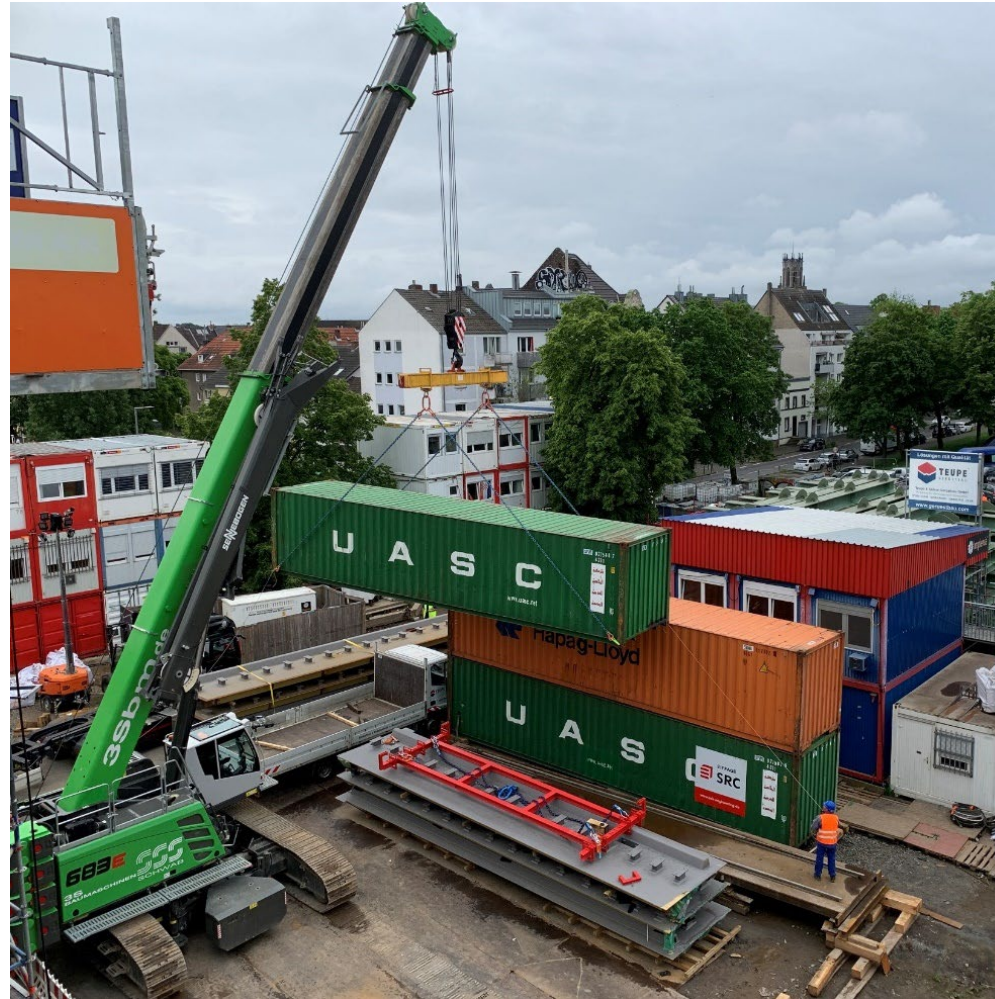
Raupenkran für Plattenhandling
