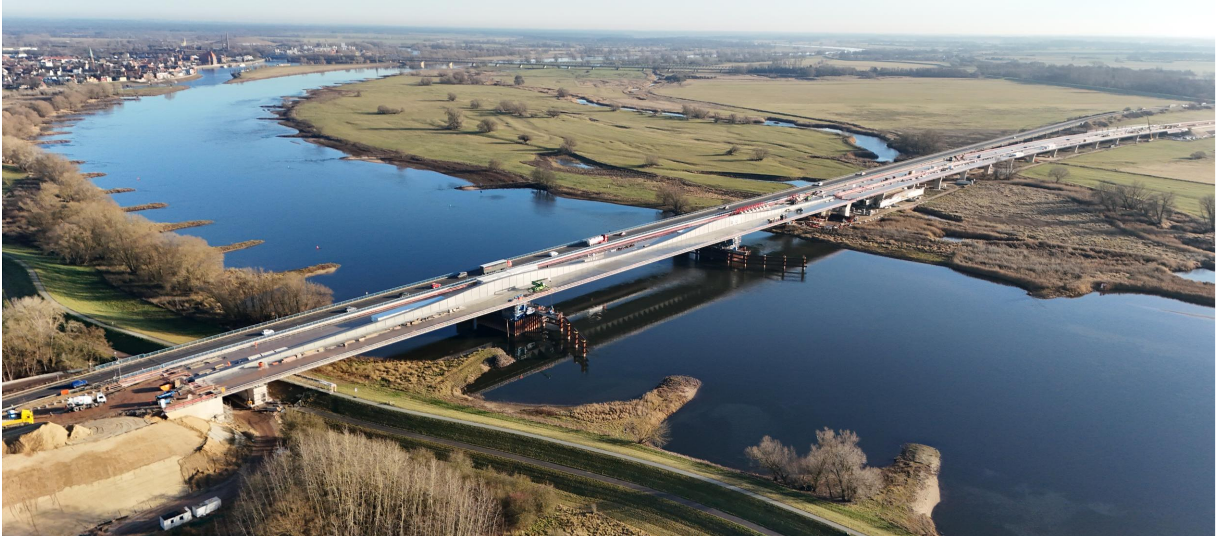
Foto: DSD Brückenbau
