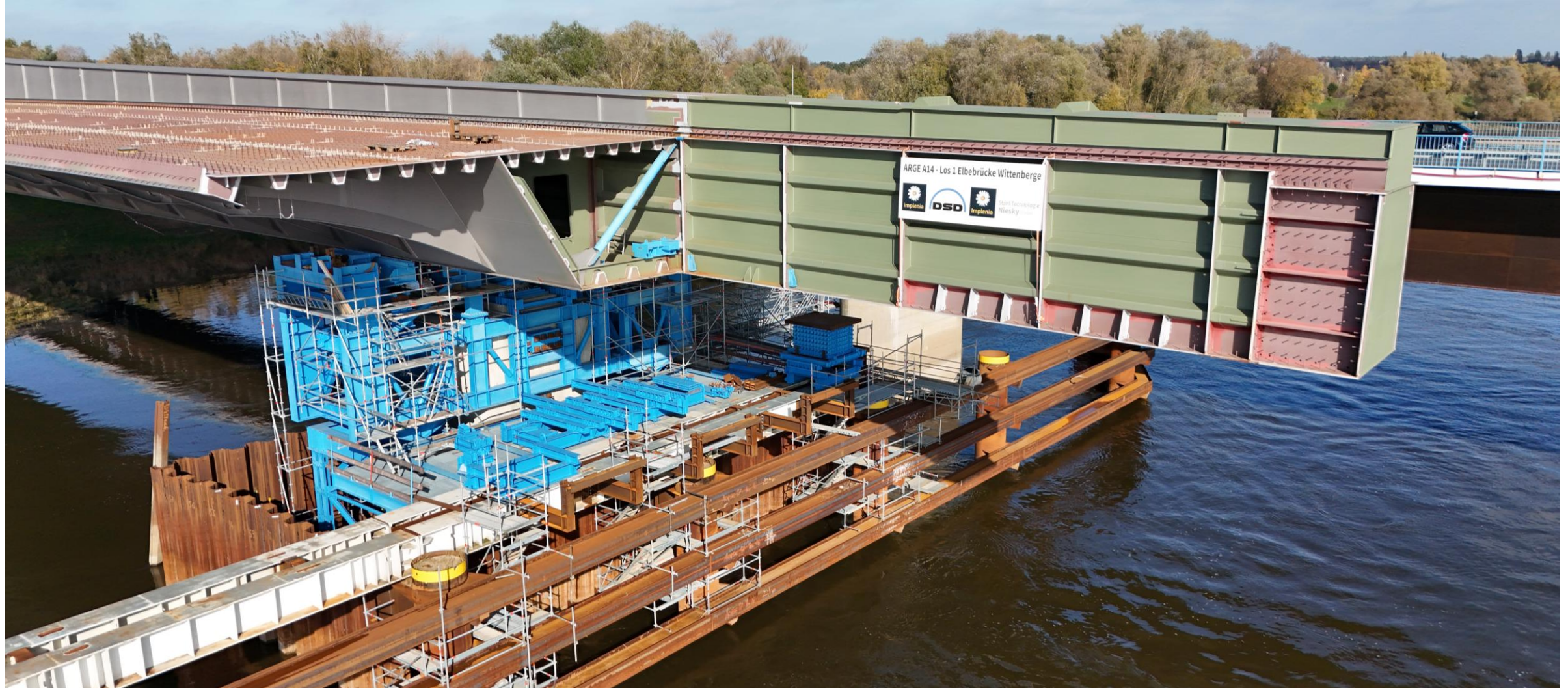
Foto: DSD Brückenbau
